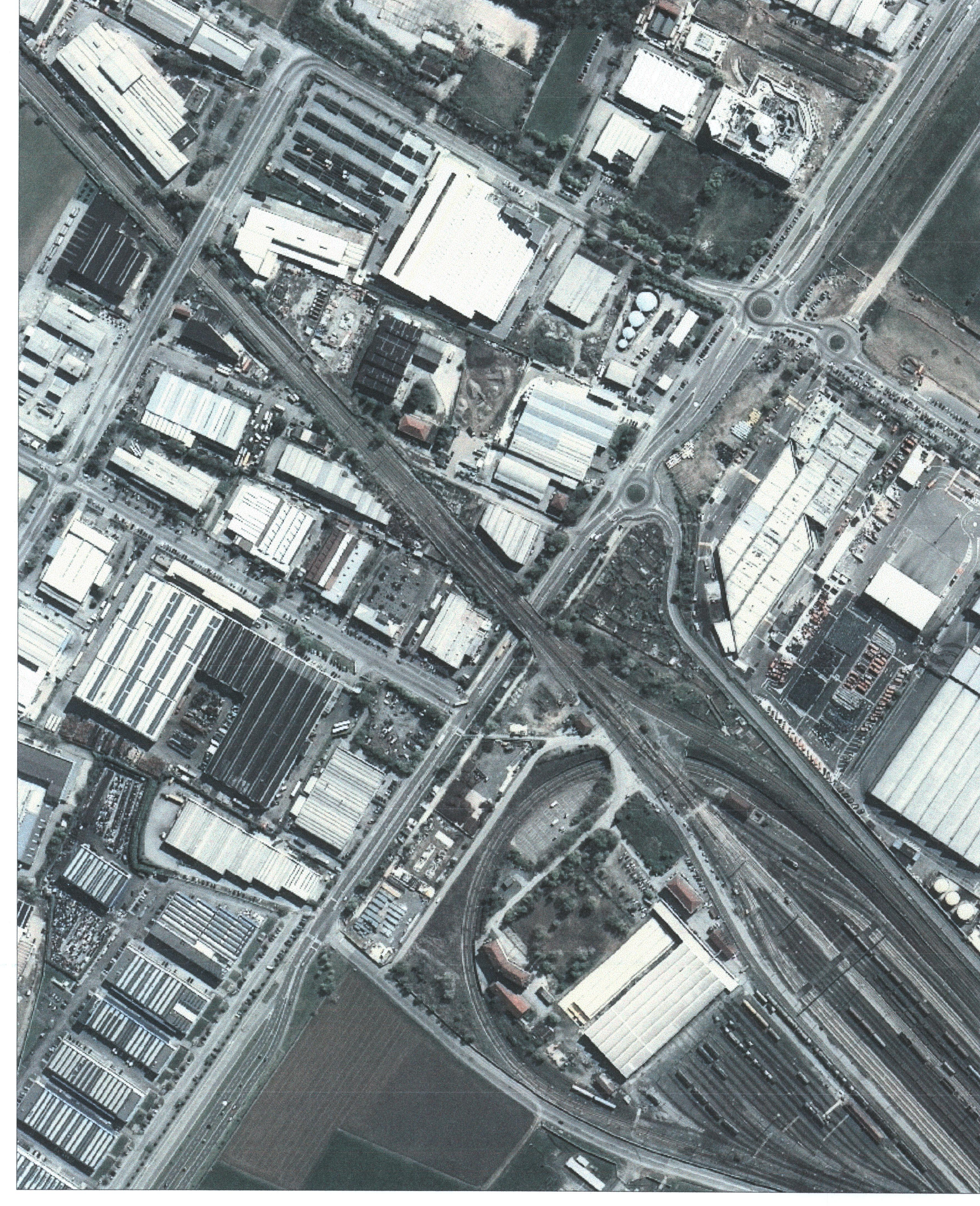
Ortofoto di inquadramento dell'area
