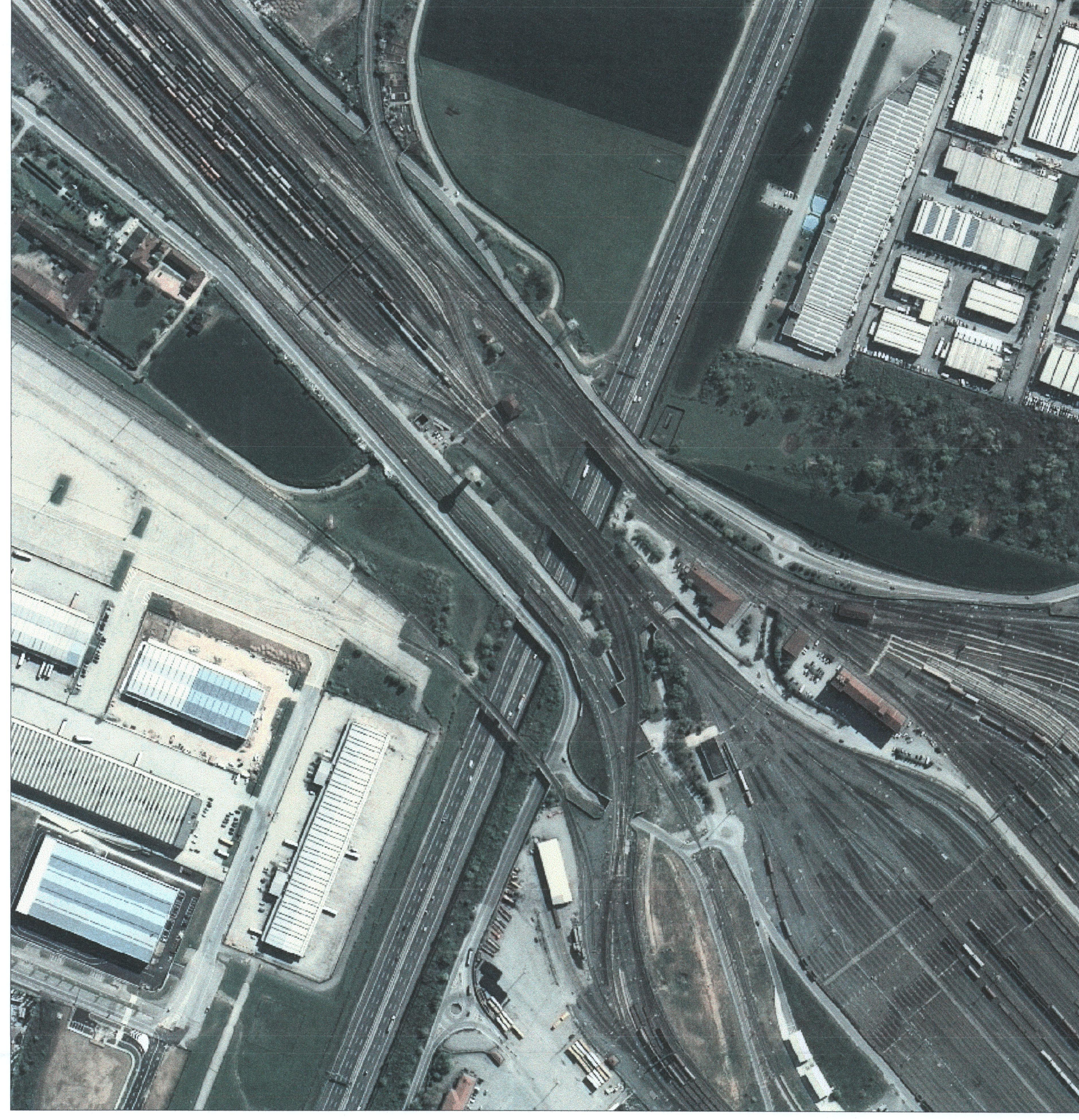
Ortofoto di inquadramento dell'area
