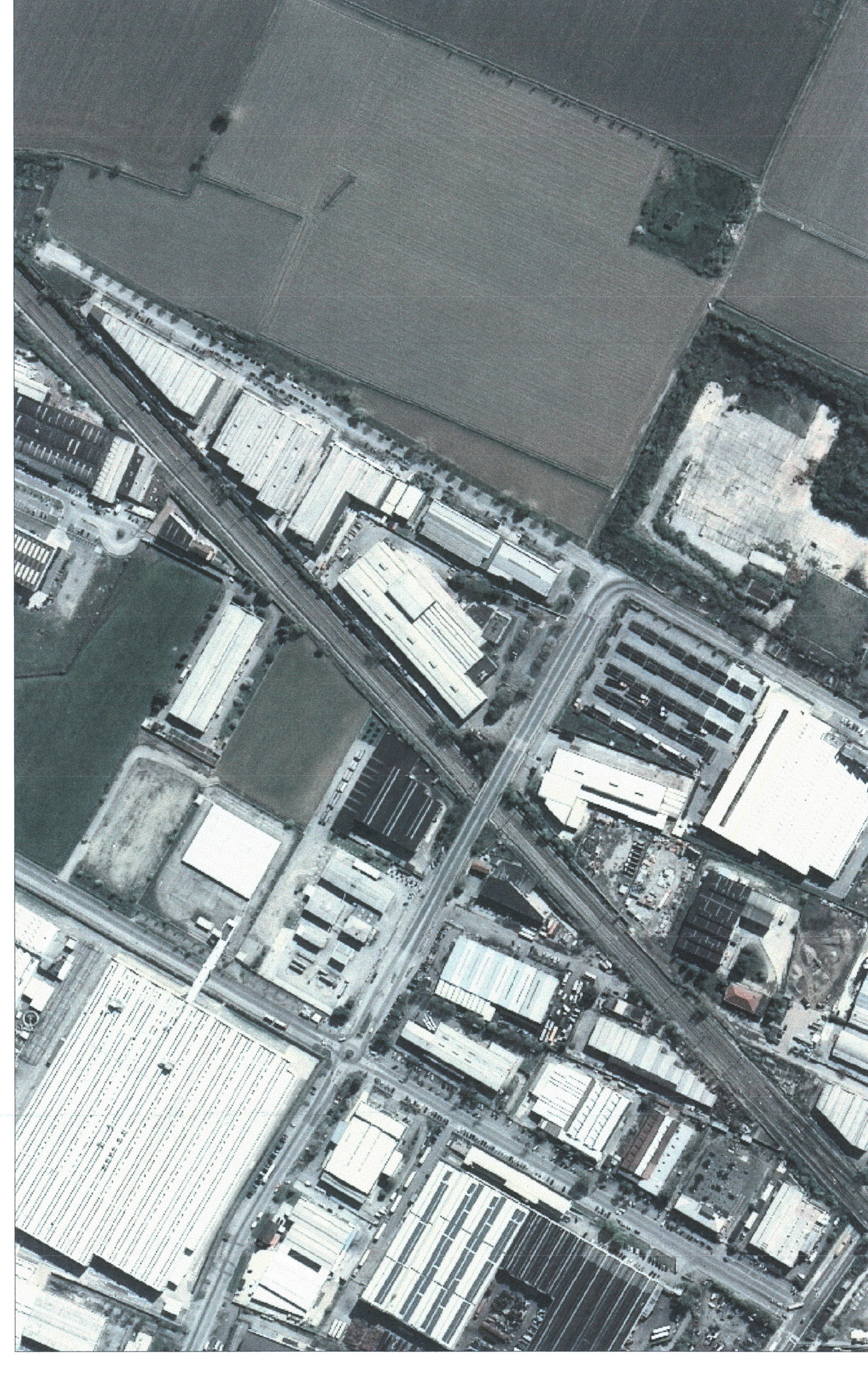
Ortofoto di inquadramento dell'area
