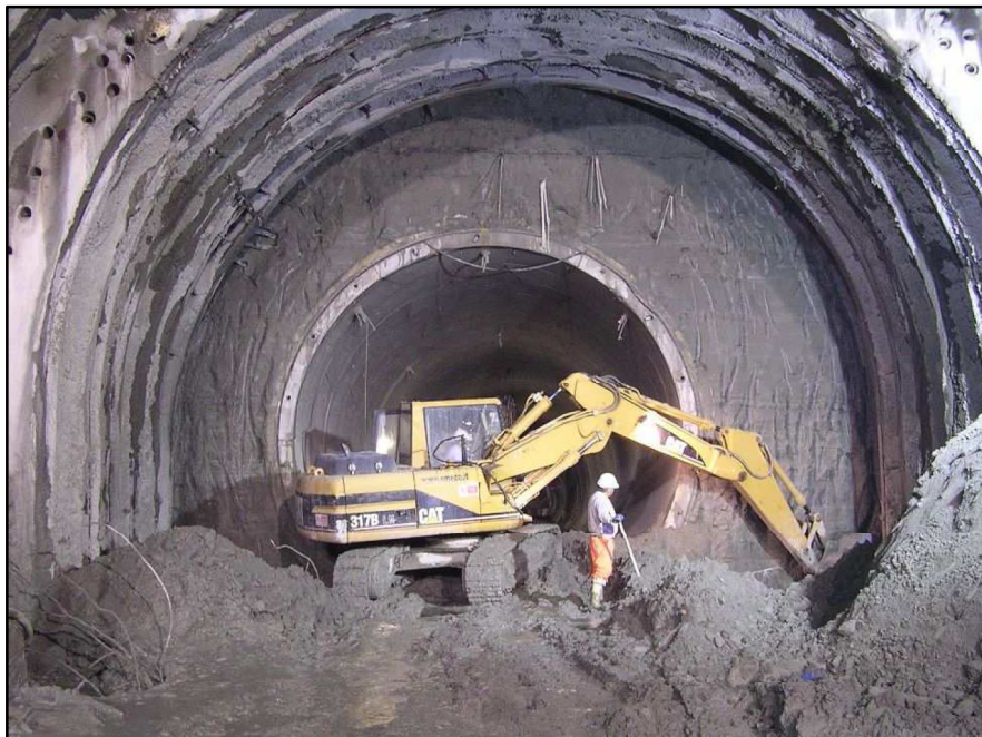
Fig. 11.12 – Il perfetto intasamento a tergo dei conchi, messo in evidenza da un successivo scavo di allargamento.
