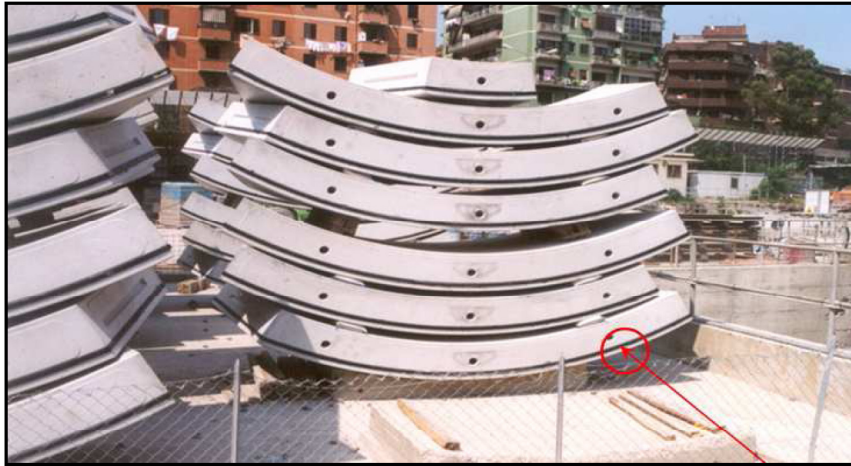
Fig. 11.5 – Conci prefabbricati con guarnizioni in neoprene a tenuta.
