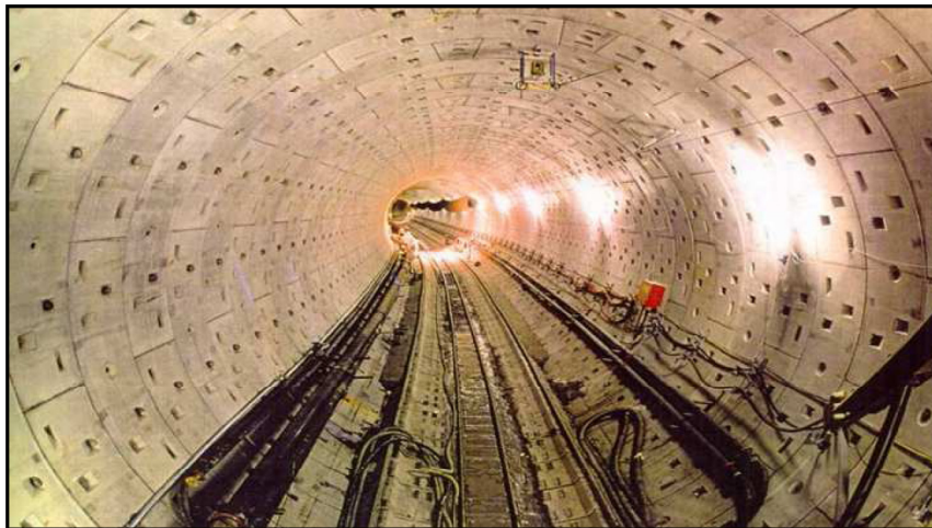
Fig. 11.6 – Rivestimento con conci prefabbricati.
